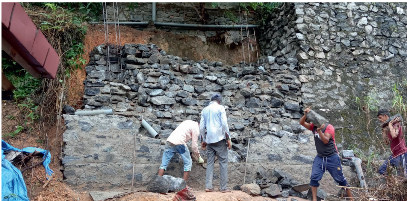
Förstärkningsarbete Suhada Home.
