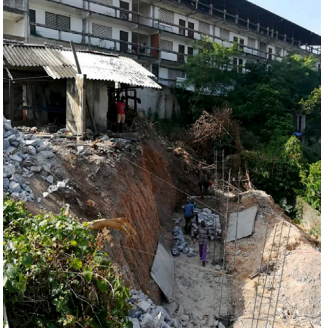
Suhada Home förstärkningsarbeten.
